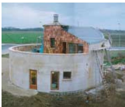
Toit HESPUL 97-900 SCI ODAL. Source : Hespul
